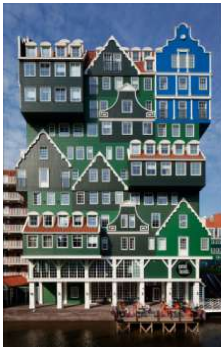
Architect Wilfried van Winden (WAM architecten) fotograaf: Peter Barnes
